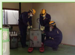
保管倉庫からの 搬出作業
