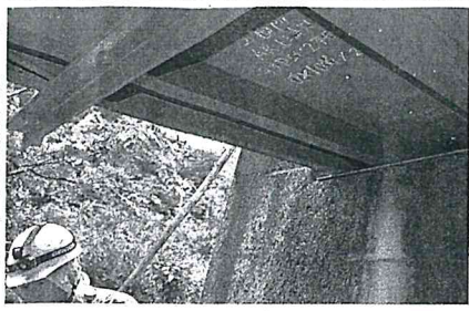
PCBの検査が行われた橋。防護服に身を包んだ作業員が裏側の塗料を採取し、検査機で分析する(浜松市で)
