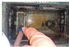
網カゴ、槽内を手作業で洗浄
