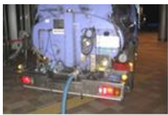
専用車輛 (バキューム車)にて作業
